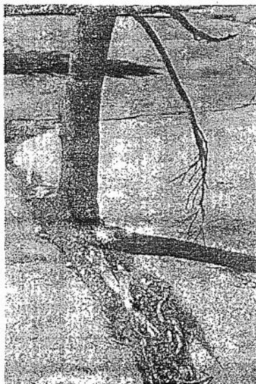
17. ábra: A növények gyökerének repesztő hatása
