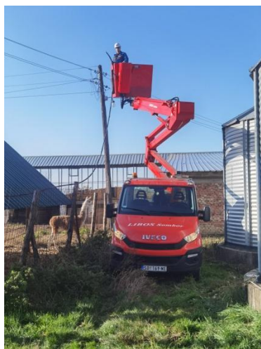
Замена ваздушних електричних каблова на целој економији
