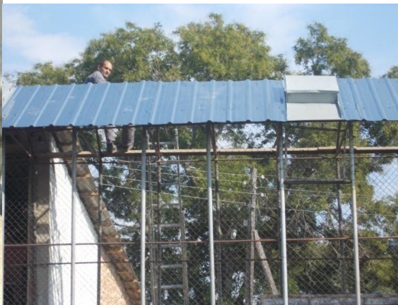
Замена крова на чардаку и на мешаони
