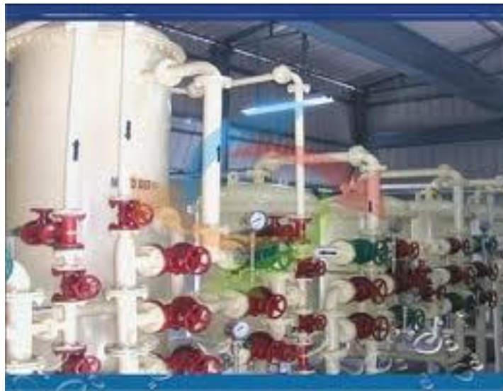
12. ábra: Ioncserélő oszlop
