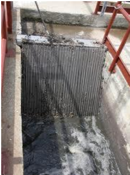
6. ábra: Előszűrő rács szennyvízkezelésnél és a rácsszemét folyamatos eltávolítása
